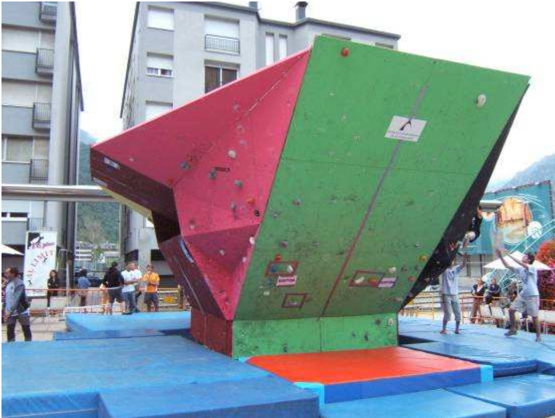
Les modificacions del rocòdrom de la FEEC han permès incrementar la superfície escalable en quasi bé el doble.
